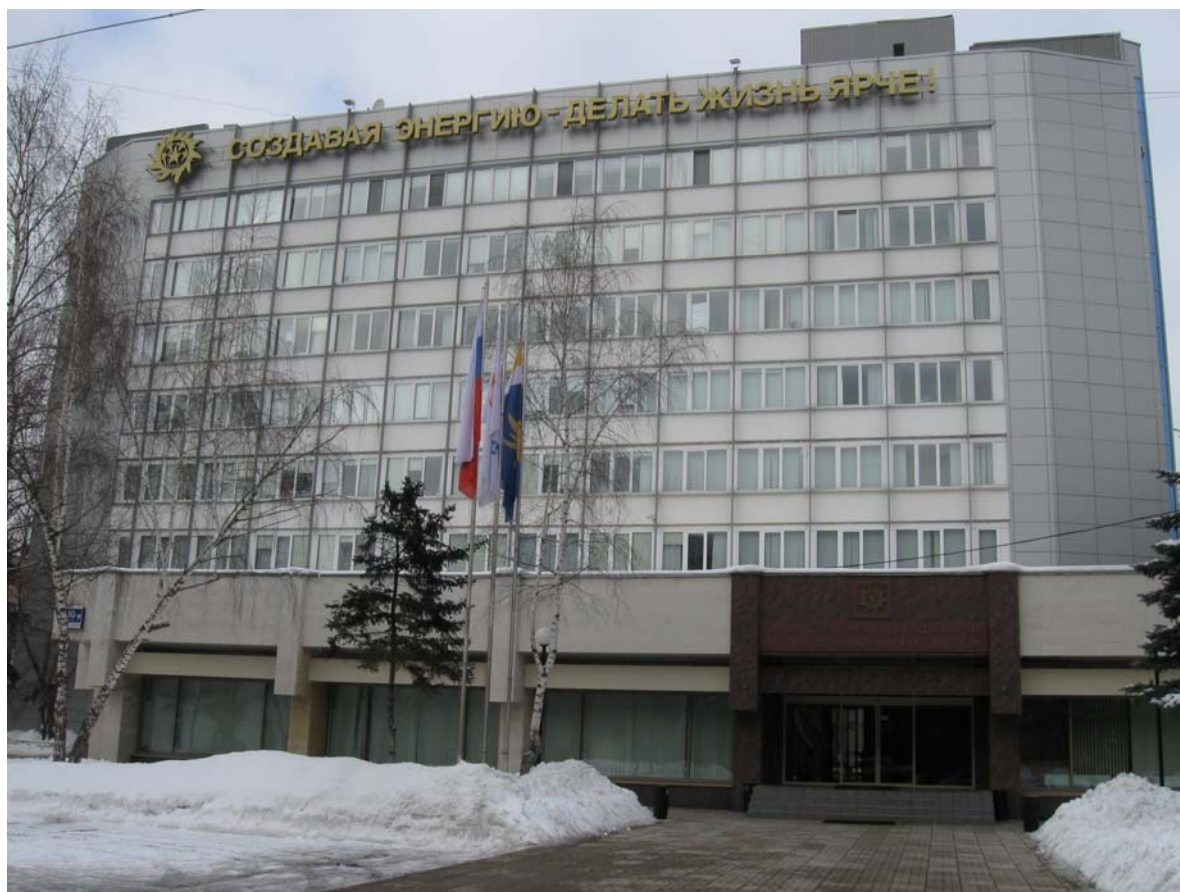
Здание № 1 (4-й Сетуньский проезд, д. 10А, стр. 2)
