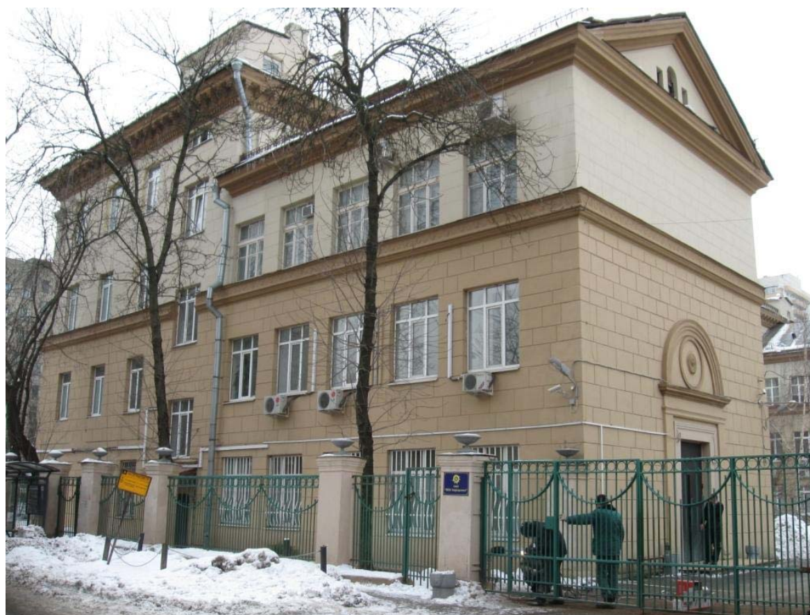
Здание № 2 (3-й Сетуньский проезд, д. 10)
