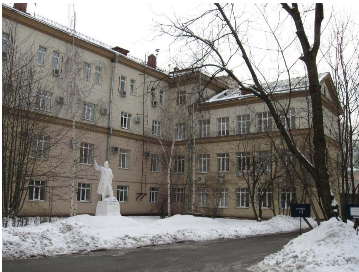
Здание № 2 (3-й Сетуньский проезд, д. 10)
